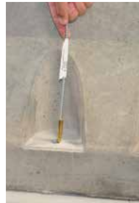
Εικόνα 5d: Βούρτσισμα της οπής
