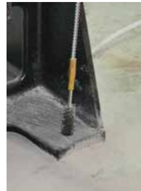
Εικόνα 8d: Καθαρισμός οπής
