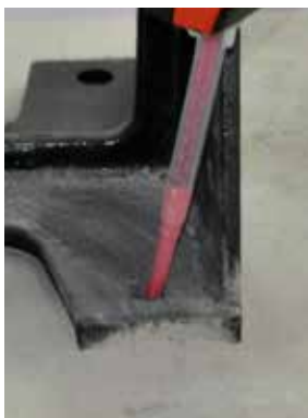
Εικόνα 9a: Πλήρωση με κονίαμα ένωσης
