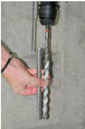
Εικόνα 5a: Ρύθμιση του βάθους διάτρησης
