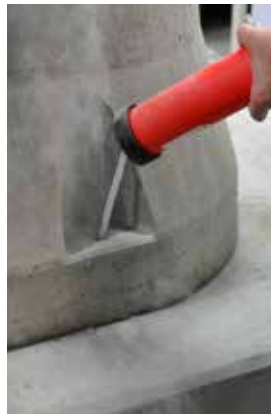
Εικόνα 5c: Καθαρισμός των οπών με πεπιεσμένο αέρα
