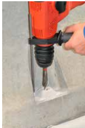
Εικόνα 5b: Διάνοιξη των οπών στερέωσης
