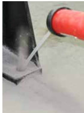
Εικόνα 8c: Καθαρισμός των οπών με πεπιεσμένο αέρα
