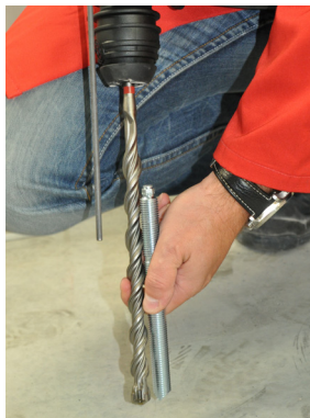
图 8b 调整钻孔深度
