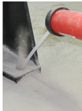
图 8c 吹扫钻孔
