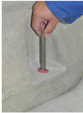
图 6b 插入配筋
