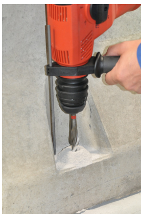
图 5b 钻固定孔
