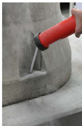
图 5c 将钻孔吹干净
