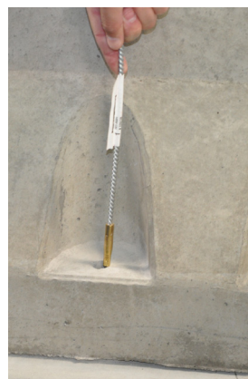
图 5d 将钻孔刷干净
