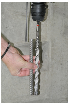
图 5a 调整钻孔深度
